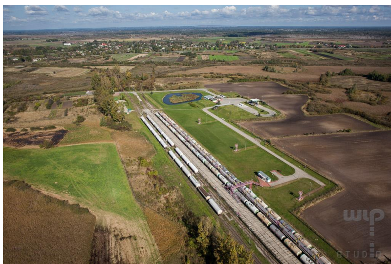
Terminal Przeładunkowy Gazu Płynnego, TEZET Sp. z o.o., www.tezet.pl – fot. WiP-Studio Lublin, www.wip-studio.pl
